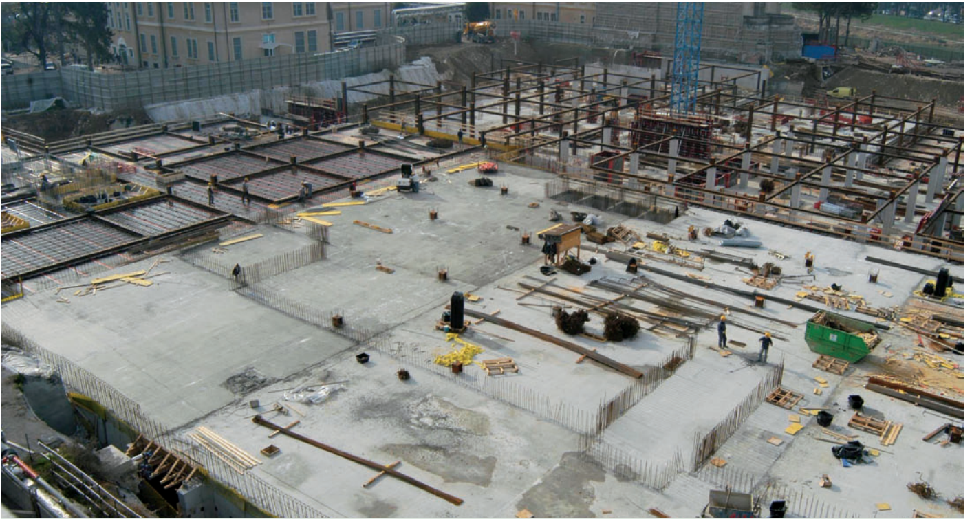
Una panoramica del cantiere del nuovo polo chirurgico di Borgo Trento
