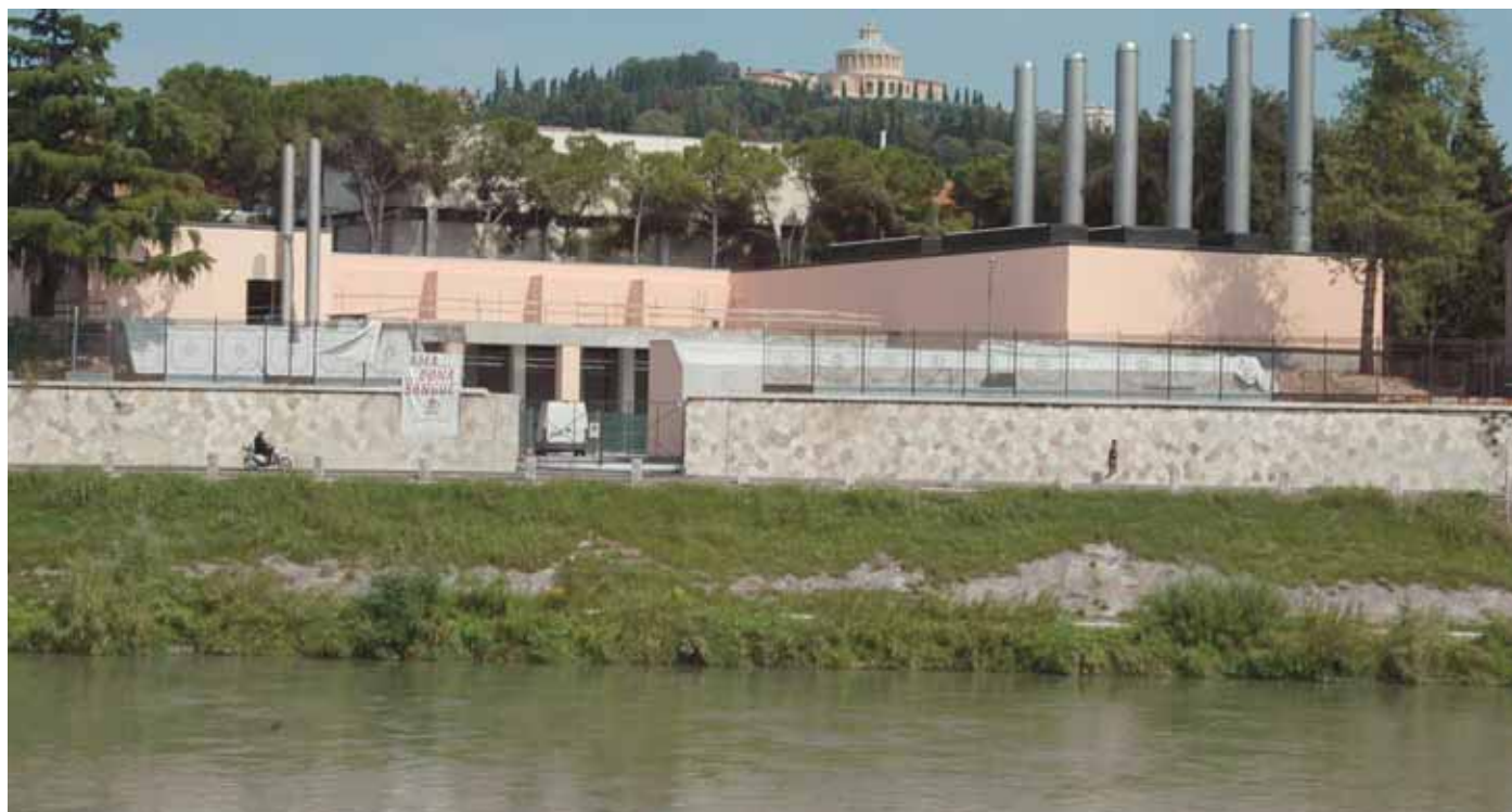
La nuova centrale termica altamente tecnologica per la produzione di caldo e freddo
