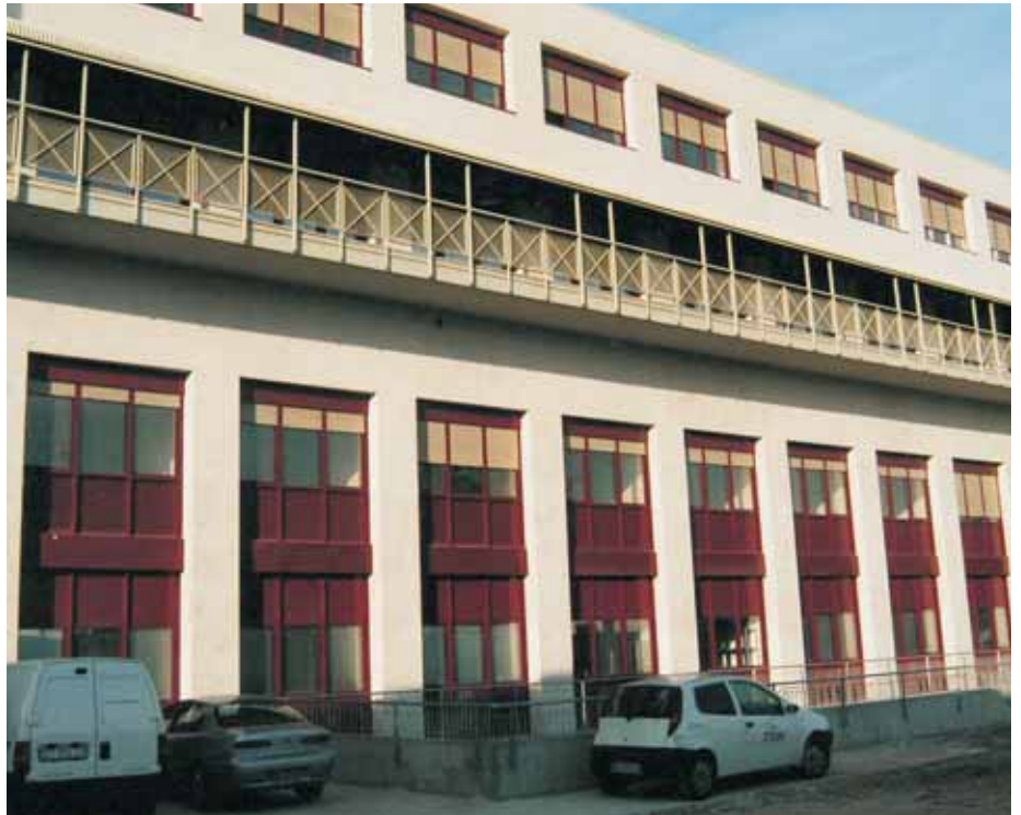
La facciata dell'Edificio Sud
